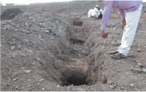
ट्रेंच का निर्माण
